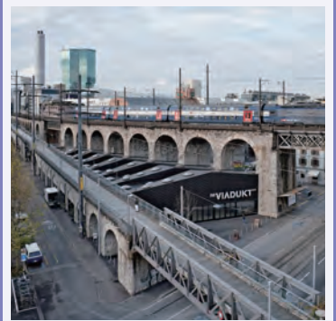
Refurbishment Viadukt Arches、スイス
