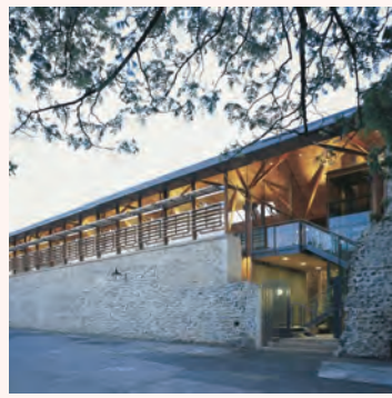
Norwich Cathedral Refectory、イギリス
